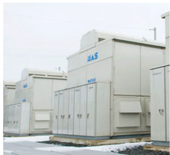
波のある風力発電の電力を一定にするNAS電池
